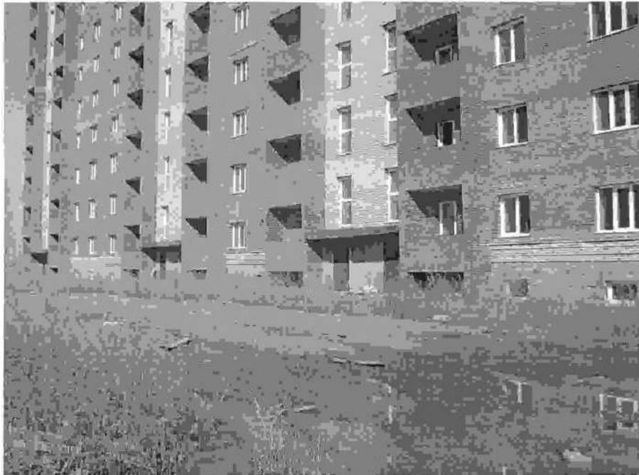
Фото 4. Главный фасад, Отсутствие тамбура. Секция 1, 2, 3. Состояние на 01.04.2015г.
