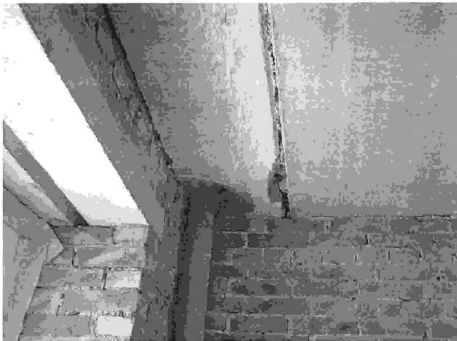
Фото 41. Разбито 2/3 плиты у опоры. Секция 8. Состояние на 01.04.2015г.
