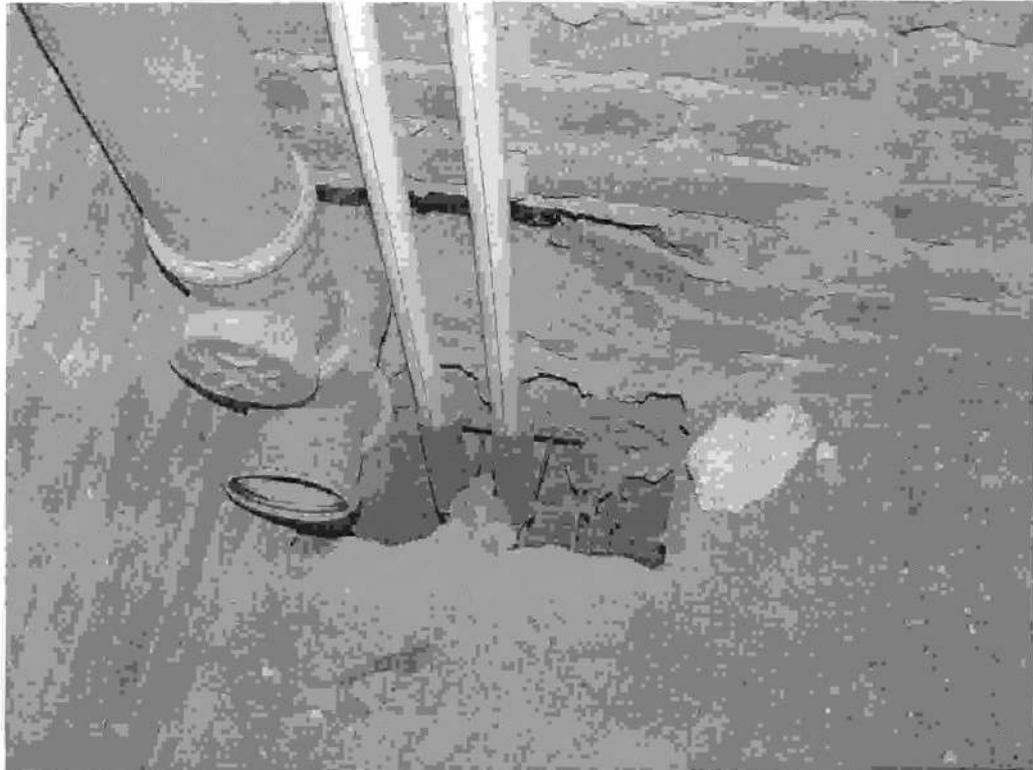
Фото 39. Отверстие в плите, перебито 4 пустоты. Секция 4. Состояние на 01.04.2015г.
