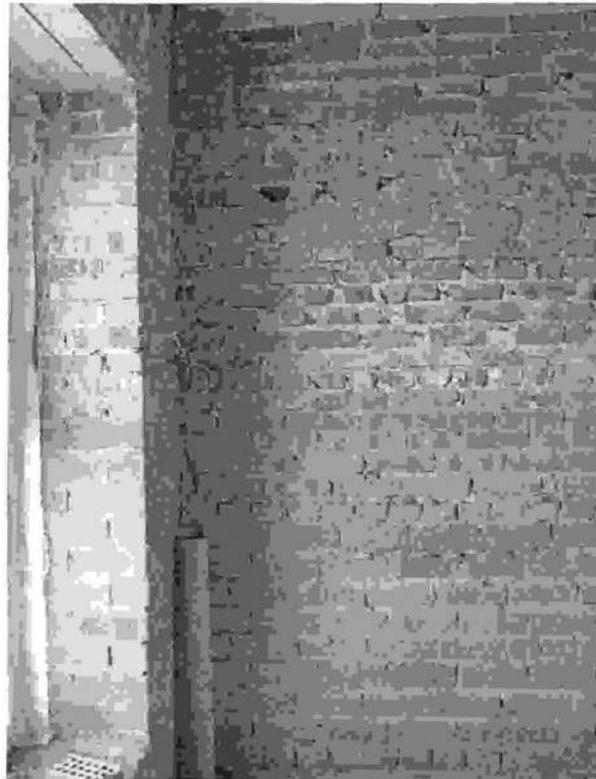
Фото 13. Кирпичная кладка наружной и внутренней стены из 3х видов кирпича. Секция 7, 4 этаж. Состояние на 02.04.2015г.
