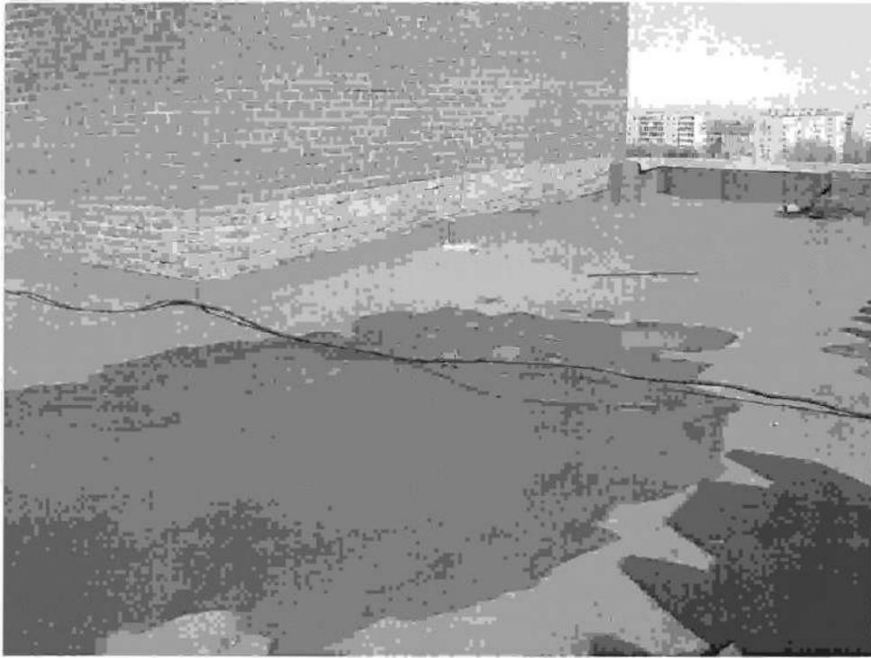
Фото 53. Уклон кровли не к воронке. Секция 11 . Состояние на 01.04.2015г
