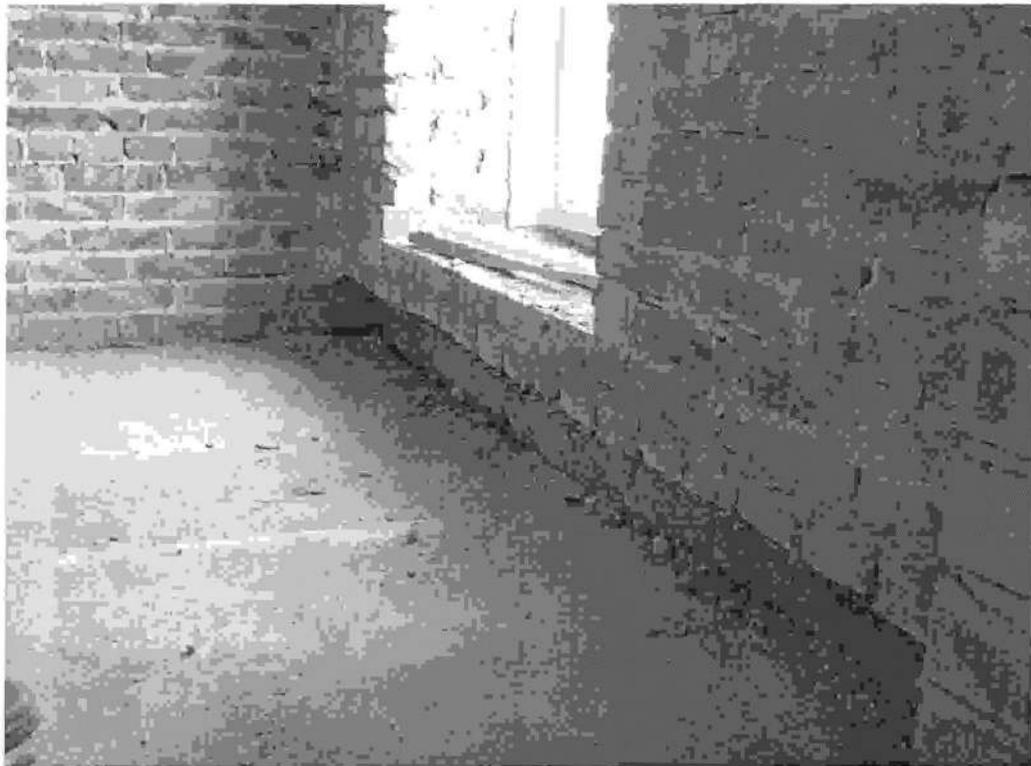
Фото 46. Оставленная штраба. Секция 8. Состояние на 01.04.2015г
