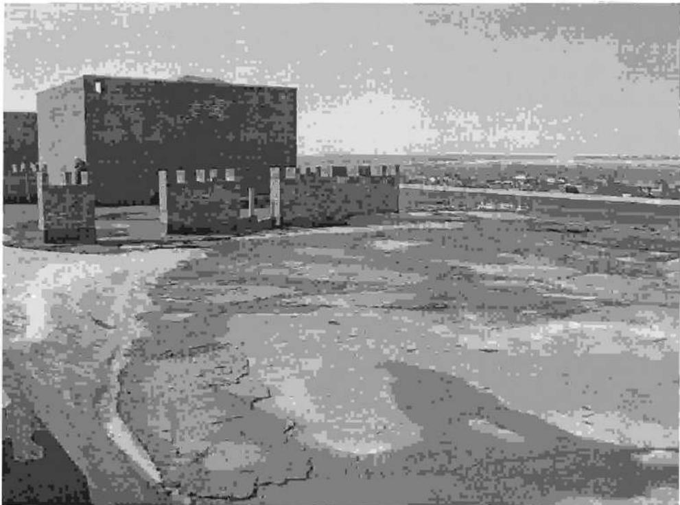
Фото 56. Отсутствует кровельное покрытие. Секция 6 . Состояние на 01.04.2015г
