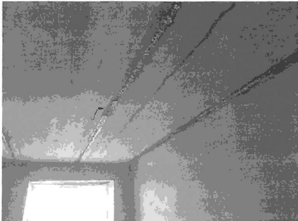
Фото 42. Продольная трещина плиты покрытия. Секция 12. Состояние на 09.04.2015г.
