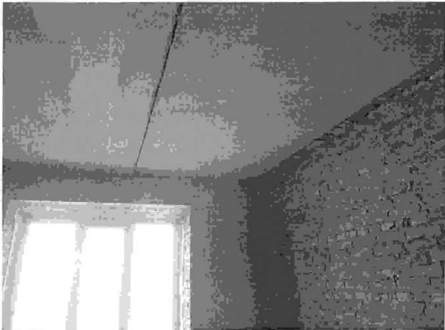
Фото 40. Монолитный участок, плиты в разных уровнях. Секция 5. Состояние на 09.04.2015г.
