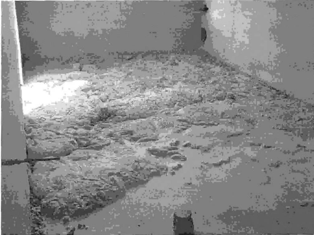
Фото 51. 30% стяжки на 100-120мм толщиной. Секция 3 . Состояние на 01.04.2015г
