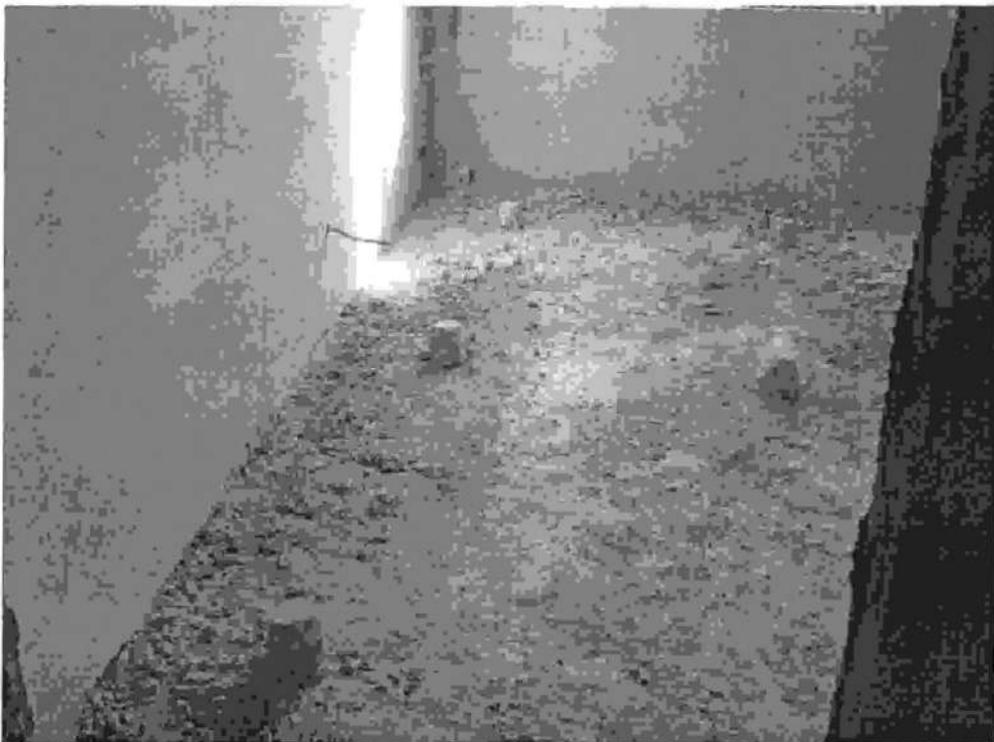
Фото 50. Маяки стяжки 110мм. Секция 3 . Состояние на 01.04.2015г
