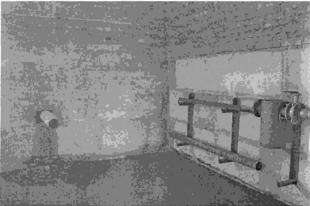
Фото 7. Подвал, секция 7. Водомерная рамка, ввод. Состояние на 02.04.2015г.
